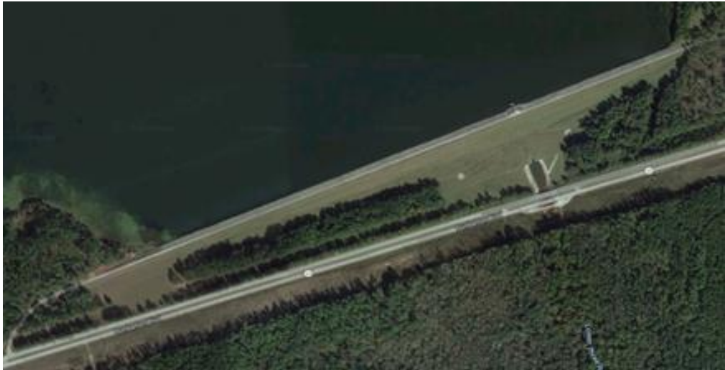
PAR Pond Dam
